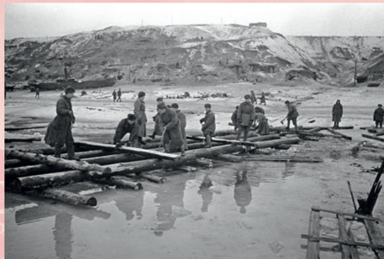
Советские сапёры из 1-й понтонно-мостовой роты капитана Виктора Корикова, 107-го отдельного моторизованного понтонно-мостового батальона строят переправу через Волгу в Сталинграде. Октябрь 1942 года. Фото Георгия Зельмы / РИА Новости. Георгий Зельма: «Бой в Сталинграде, жестокий шестидесятидневный бой не утихал ведь ни на одну-единую минуту! И какая разница: ночь или день? Наши солдаты насмерть отстаивали узкую полоску земли, прижатую к Волге. Гитлер бросал на нас дивизию за дивизией, в небе кружили тысячи фашистских самолётов. А страх, холодный, нестерпимый страх, пришёл ко мне только декабрьской ночью 1942 года, когда на буксирном катере с ранеными я впервые переправился на левый берег проявлять свои плёнки. Над рекой беспрерывно, с противным воем лопались немецкие световые ракеты. То тут, то там плюхались в чёрную воду снаряды. А на том берегу, откуда я приплыл, стояло зловеще-яркое зарево».
