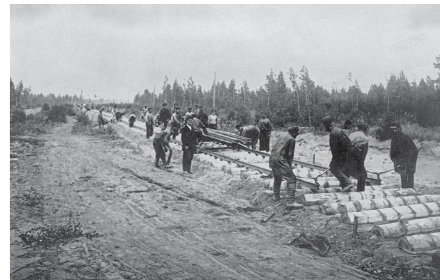
Укладка пути. «Виды сооружения Средне-Сибирской железной дороги», 1890-е годы
