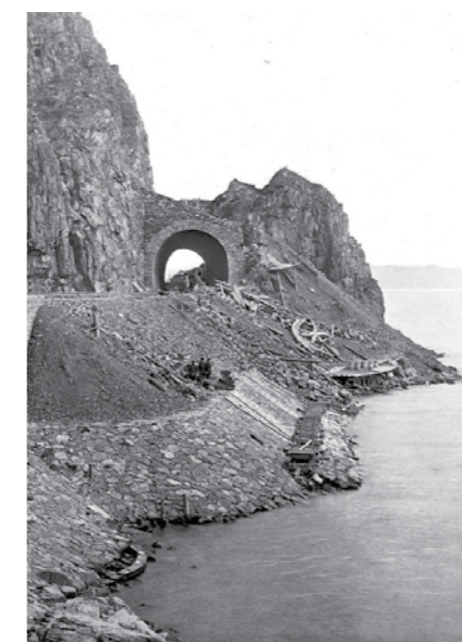
Мост в 1 сажень и галерея на 12 версте. Альбом построек и видов Кругобайкальской железной дороги 1900–1904 гг. (ЦМЖТ)
