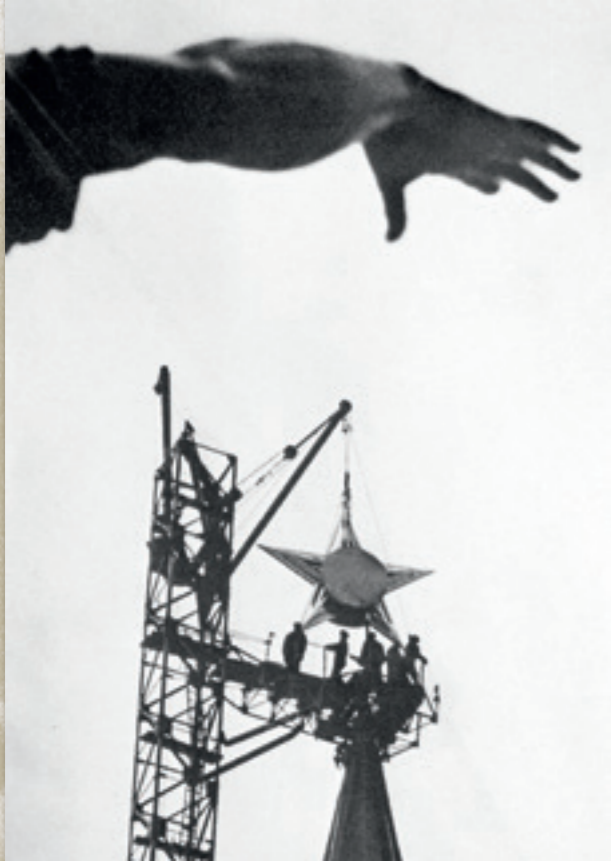
Установка звезды на Спасской башне Кремля в 1935 году. Первые кремлёвские звёзды были выполнены из бронзы и нержавеющей стали, инкрустированы уральскими самоцветами. Их заменят всего через два года на светящиеся рубиновые. Звезда со Спасской башни украсит шпиль Речного вокзала. Фото РИА Новости
