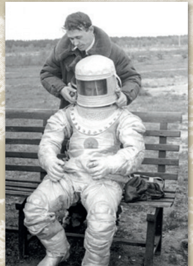
Конструктор Евгений Чертовский (стоит) и лётчик-испытатель Сергей Коробов (сидит) на испытаниях нового высотного скафандра Ч-3. 1937 год. Фото Павла Трошкина
