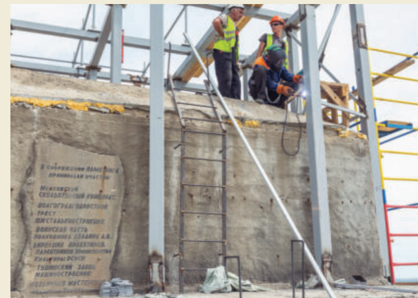
Реставрационные работы на стилобате вернули ему изначальный вид. Фото предоставлено Музеем-заповедником «Сталинградская битва»
